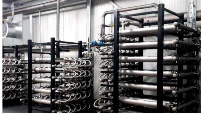
Рис. 2. Блок змішування HoSt Blend та мембранні модулі [7].
