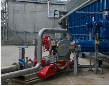
Рис. 2. Блок змішування HoSt Blend та мембранні модулі [7].
